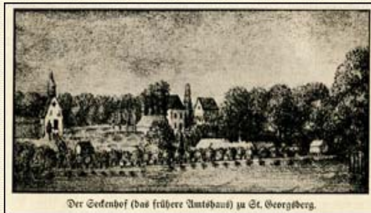
Der Seckenhof (das frühere Amtshaus) zu St. Georgsberg.
