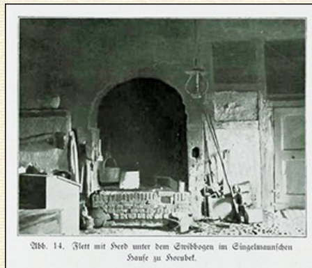
Abb. 14. Flett mit Herd unter dem Swibbogen im Singelmannschen Hause zu Hornbek.
