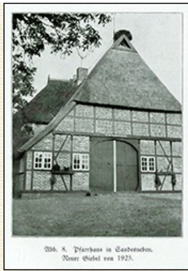
Abb. 8 . Pfarrhaus in Sandesneben. Neuer Giebel von 1925 .
