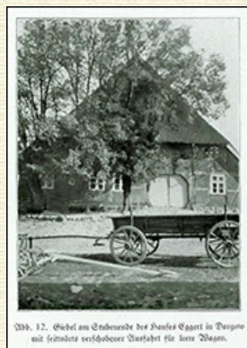
Abb. 12. Giebel am Stubenende des Hauses Eggert in Dargow mit seitwärts verschobener Ausfahrt für leere Wagen.
