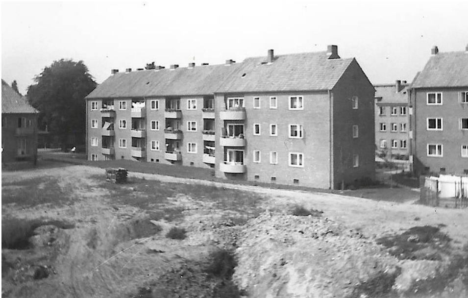
Hinter dem Wohnblock tat sich lange eine große Baustelle auf, bis endlich weitergebaut werden konnte.
