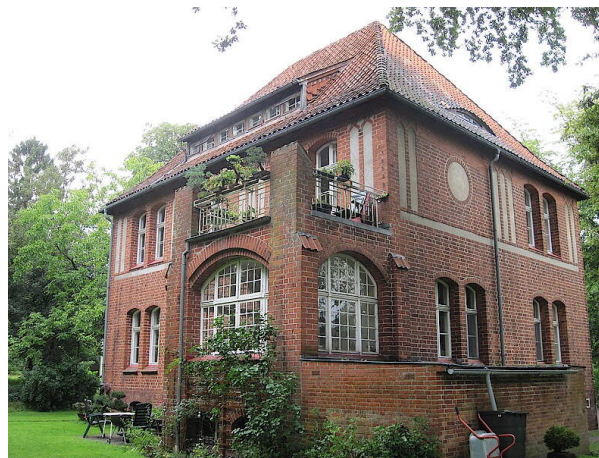
Chefarztwohnhause, Kelmstr. 11 (Gartenansicht)
