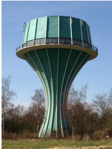
Der Wasserturm im Volkspark
