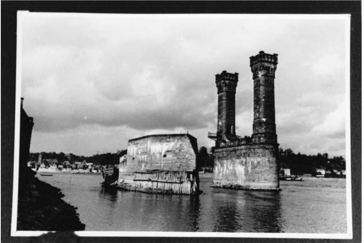
Foto: Zerstörte Eisenbahnbrücke über die Elbe bei Lauenburg
