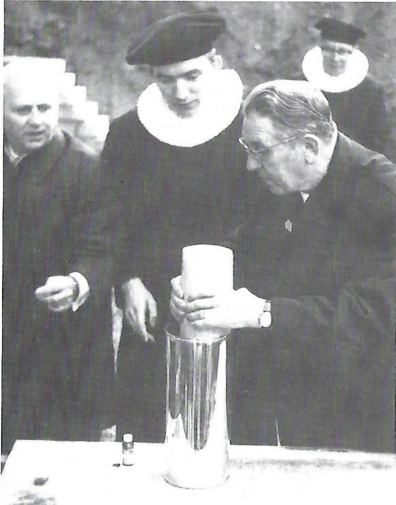
Grundsteinlegung für das kleine Gemeindezentrum Eilbeker Weg 214 am 12.5.1968.
