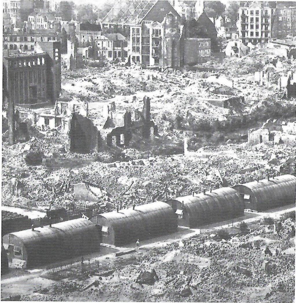
Nissenhütten im Trümmergebiet am Eilbeker Weg und der Auenstraße.
